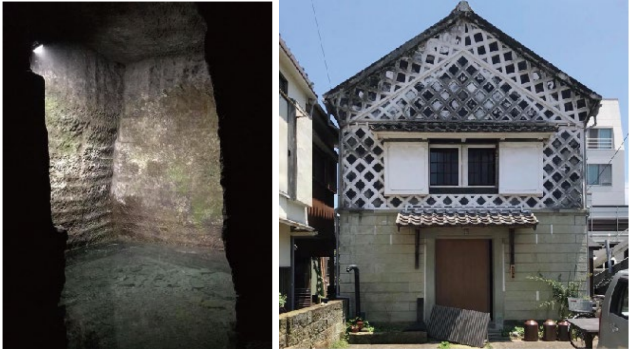
図3 伊豆石：石切場跡(松崎市室岩洞)および、なまこ壁と伊豆石の蔵(下田)
